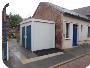
Toilettes publics provisoires sur la Place de la Mairie.
