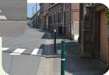
Mise aux normes des passages piétons avec dalles podotactiles.
