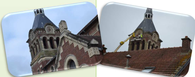
Pose d'abat-sons et de pics répulsifs à pigeons sur le clocher de l'Eglise.
