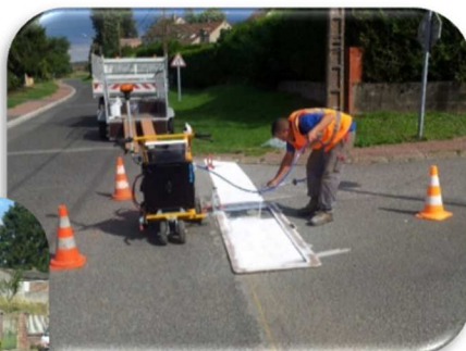
TRAÇAGE AU SOL ET CRÉATION DE PLACES DE STATIONNEMENT
