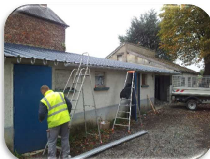
REMISE EN ÉTAT DE L'ANCIEN VESTIAIRE
